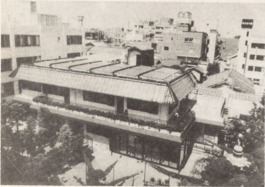
Rys. 9. Dom w Osaka (Japonia) wyposażony w przetworniki fotowoltaiczne z amorficznego krzemu
