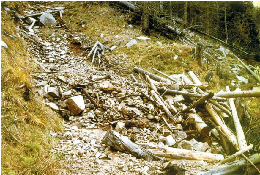
Fot. 4. Materiał gruzowy zdeponowany przed zaporą przeciwerozyjną zbudowaną w rynn timerpływu w Kotle Łomniczki. Kilka zapór zostało zniszczonych przez późniejszy spływ wód stokowych (fot. K. Parzóch)
