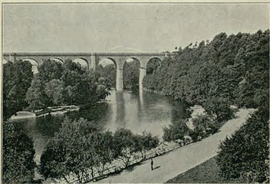
Der Neiße-Viadukt bei Görlitz.
