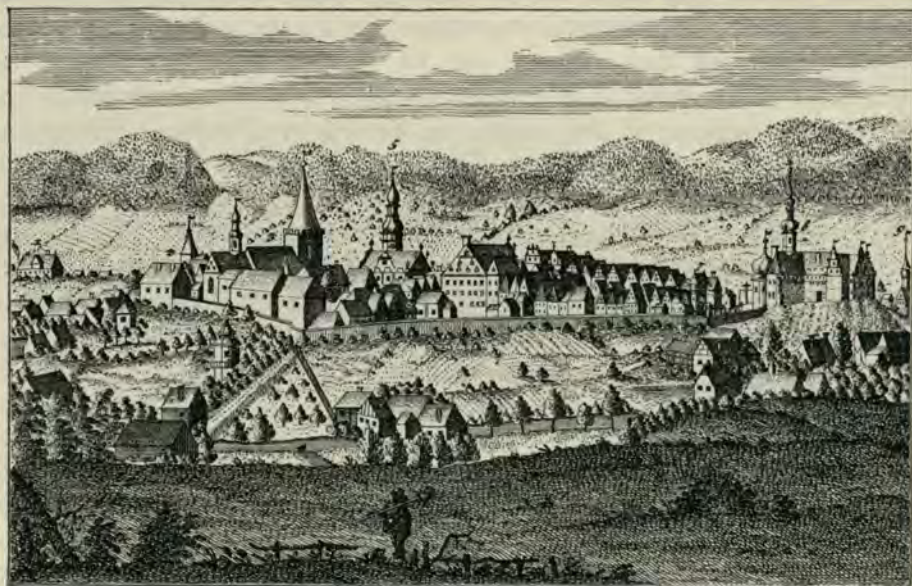
Das alte Nimptsch.
