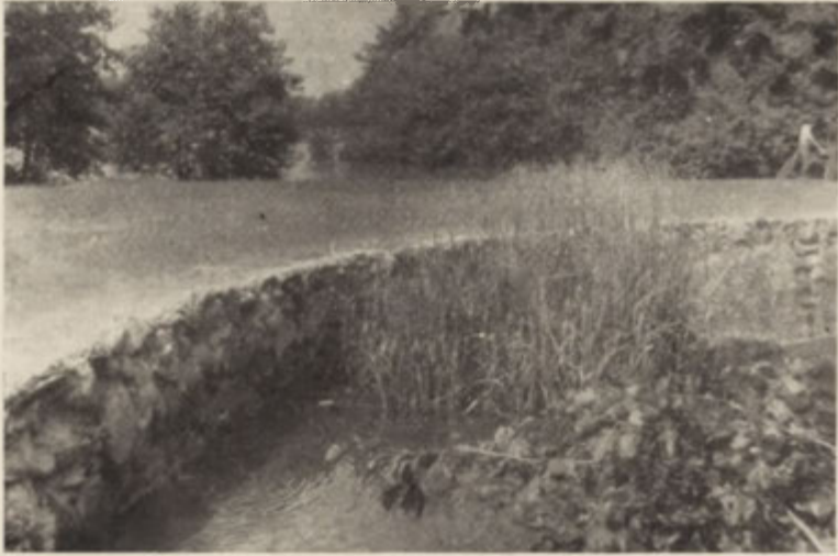
Fot. 1. Maksymalny stan wody na Pilicy w dniu 30 lipca 1960 r. Widoczne przecieki do zalewu Niebieskich Źródeł.
