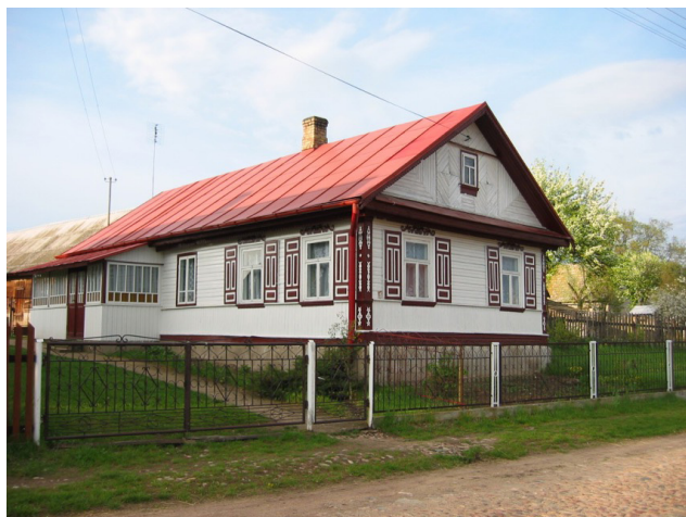
Fot. 9.14. Typowy budynek wiejski w Narwiańskim Parku Narodowym (fot. J. Bański) Typical rural building in the Narew National Park (photo by J. Bański)
