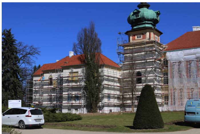
Fot. 9.4. Fragment pałacu w Łańcucie w trakcie remontu (Fot. J. Bański) Part of the palace in Łańcut during renovation (photo by J. Bański)
