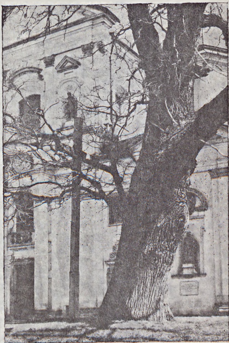
Ryc. 3. Potężny dąb szypułkowy obok zabytkowego, XVIII-wiecznego kościoła w Poświętnym. — A conspicuous pedunculate oak growing near the old XVIIIth century church at Poświętne. Fot. R. Olaczek
