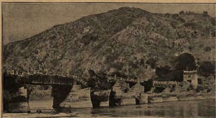
zerstörte Brücke in Peshawar.
