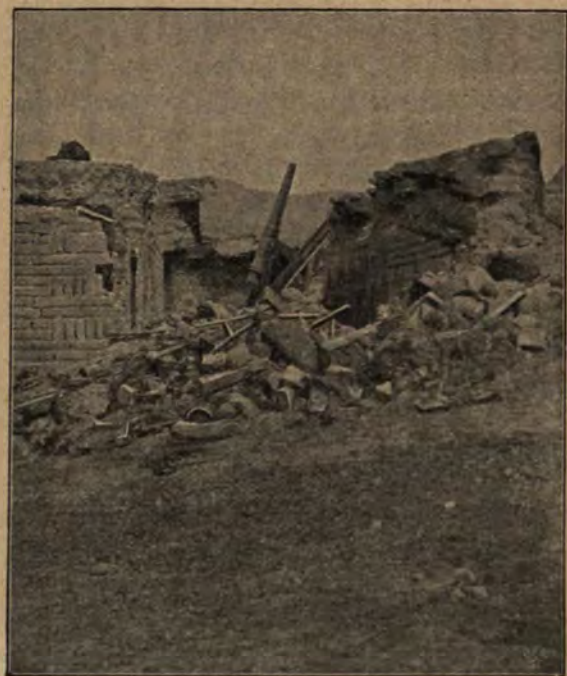
Ein Teil der zerstörten Mauer des Nordarsenals.
