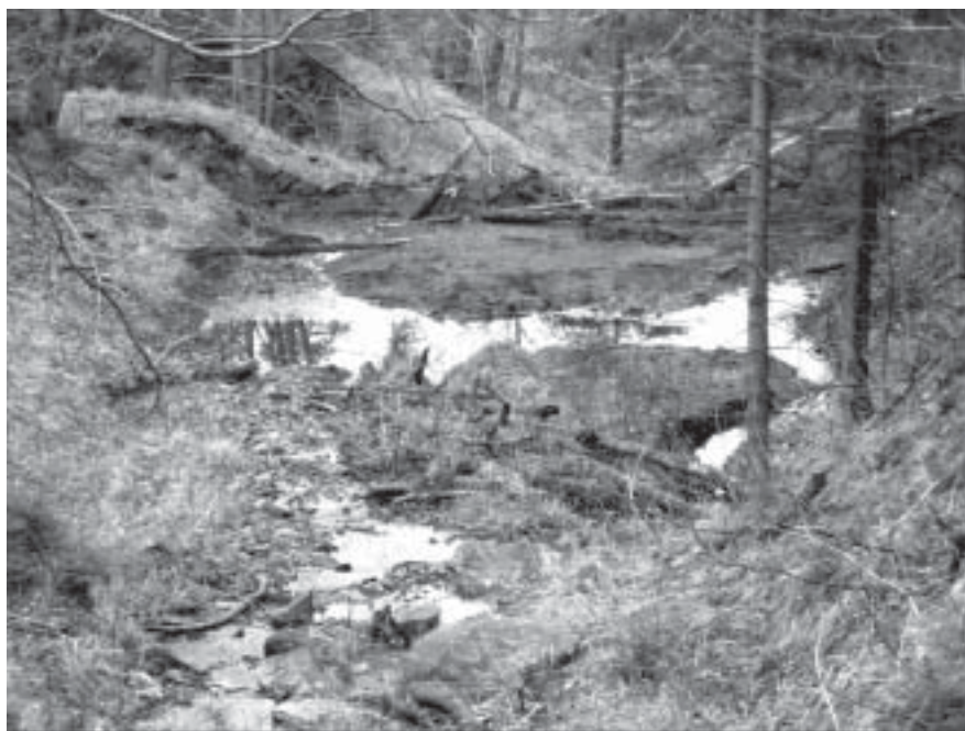
Fot. 2. Aluwia wypełniające koryto Černego Potoku powyżej zapory na stanowisku 4 Alluvium filling the Černý Potok channel above the check dam located at site 4
