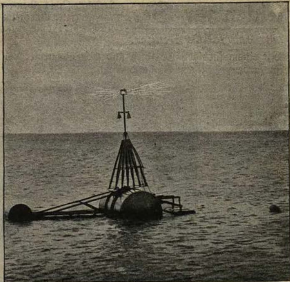
Elektrische Leuchtboje bei Wüsum in Holstein.
