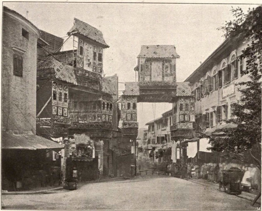
Straße in Hongkong.
