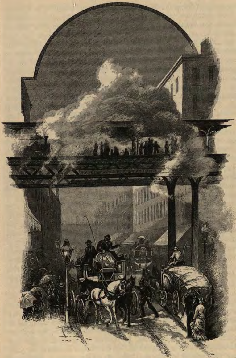
Die Straßenhochbahn in New York.
