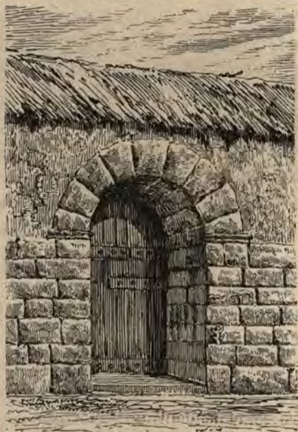
Mur ancien de palais (A B) (voy. p. 265), l'arcade, la partie supérieure du mur et la toiture datent de l'époque espagnole. — Sur le jambage gauche se trouve la grenouille figurée ci-dessus.
