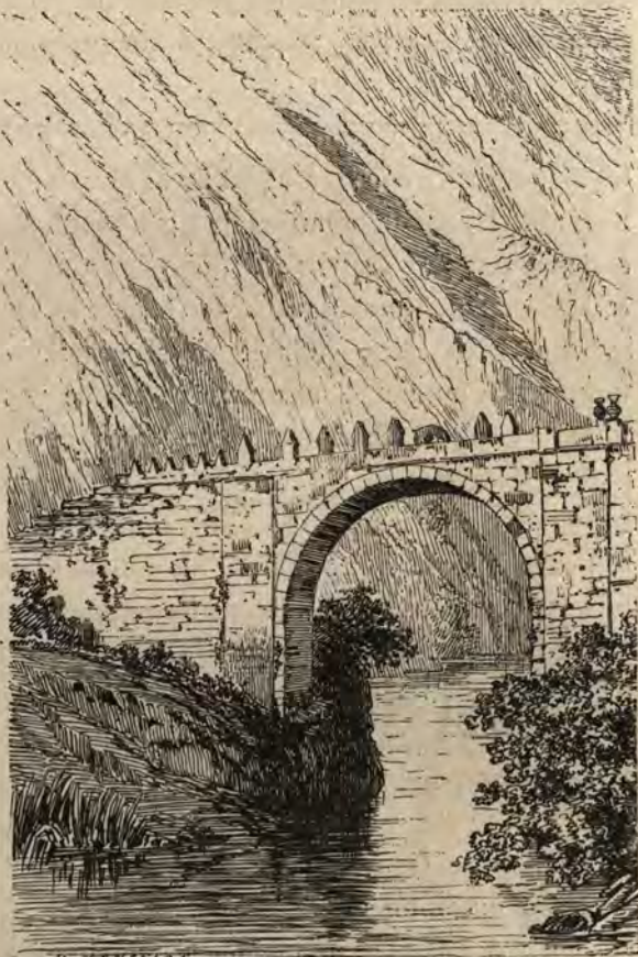
Pont en pierre, construit par les Espagnols sur le rio Pachachaca.
