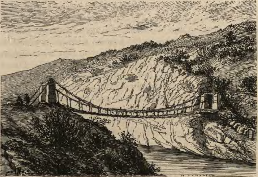
Pont en fibres de maguey sur le rio de Pachachaca.
