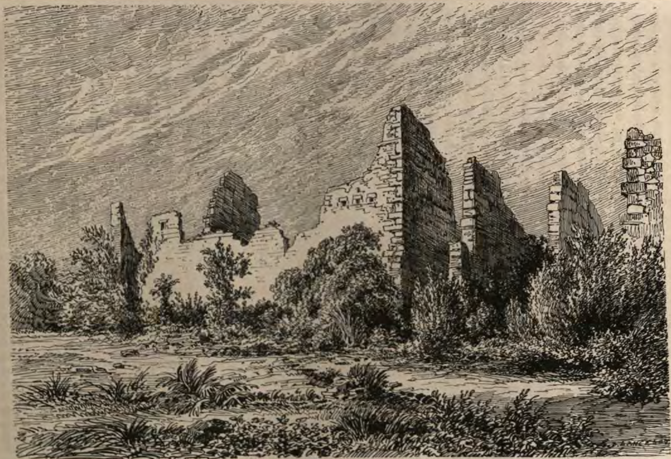
Murs du Castillo de Marca-Huamachuco, vus du sud-est
