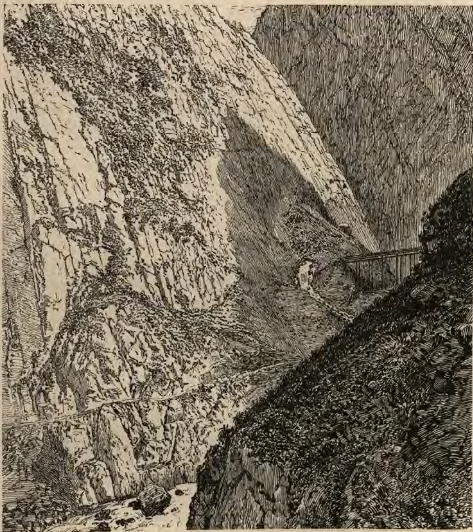
Pont en fer de la Oroya, près de l'Agua de Verugas.
