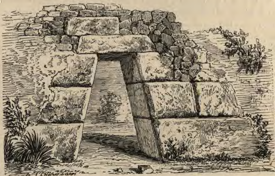
Porte sur une terrasse ( andene ), à Ollantaïtambo. (Maçonnerie appartenant à deux et peut-être à trois époques différentes.)
