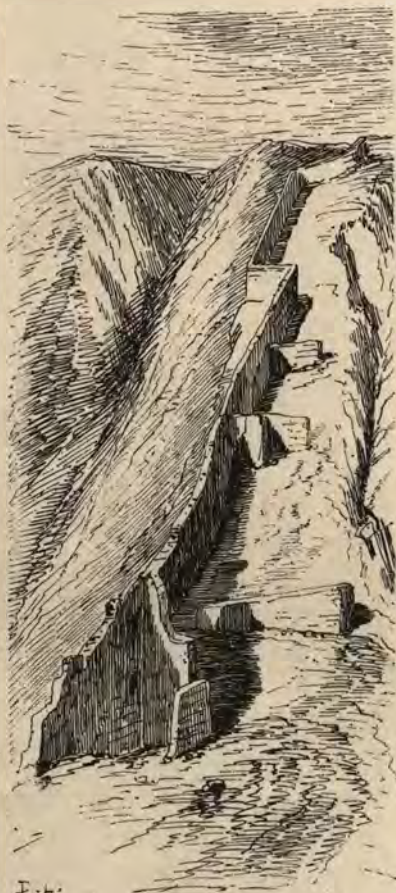
Mur de défense (forteresse de Ollantaïtambo) en schistes ardoisiers recouverts de stuc. (Page 336.)
