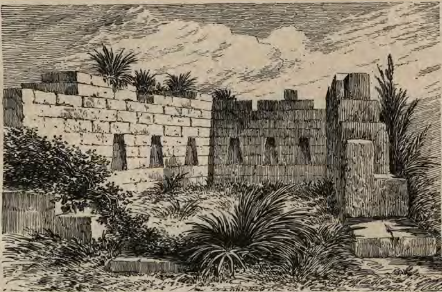
Intérieur d'une construction de l'intihuatana, à Pisacc.
