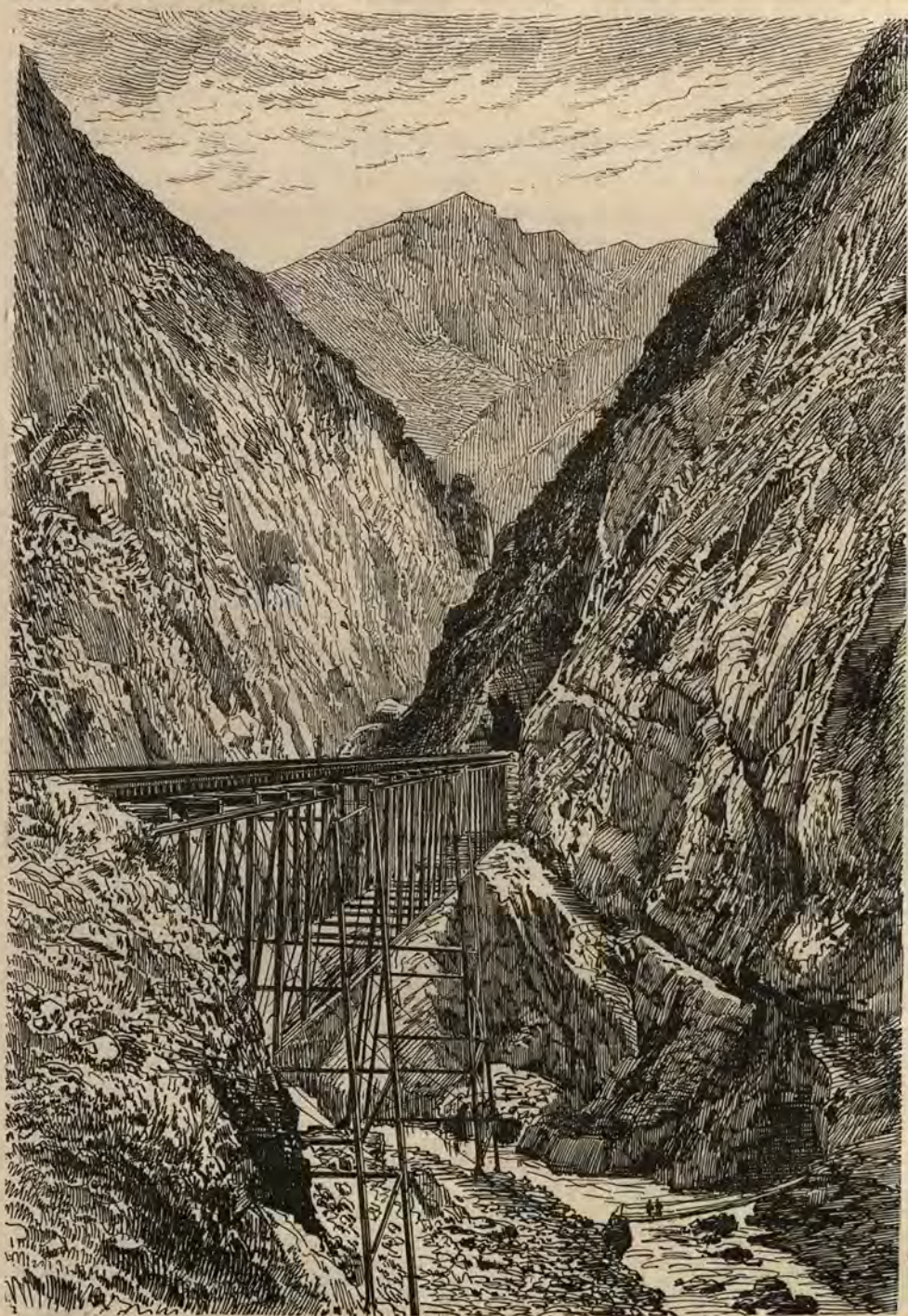
Grand pont en fonte du chemin de fer de la Oroya et l'ancien pont suspendu en fibres végétales.
