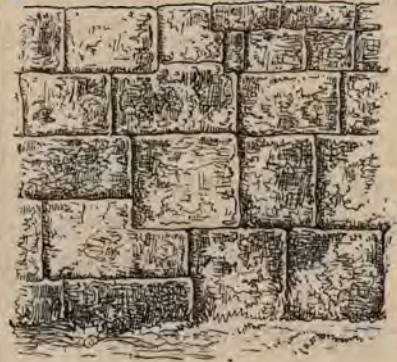
Mur de la façade nord du palais dit de l'Inca, à Cajamarca.
