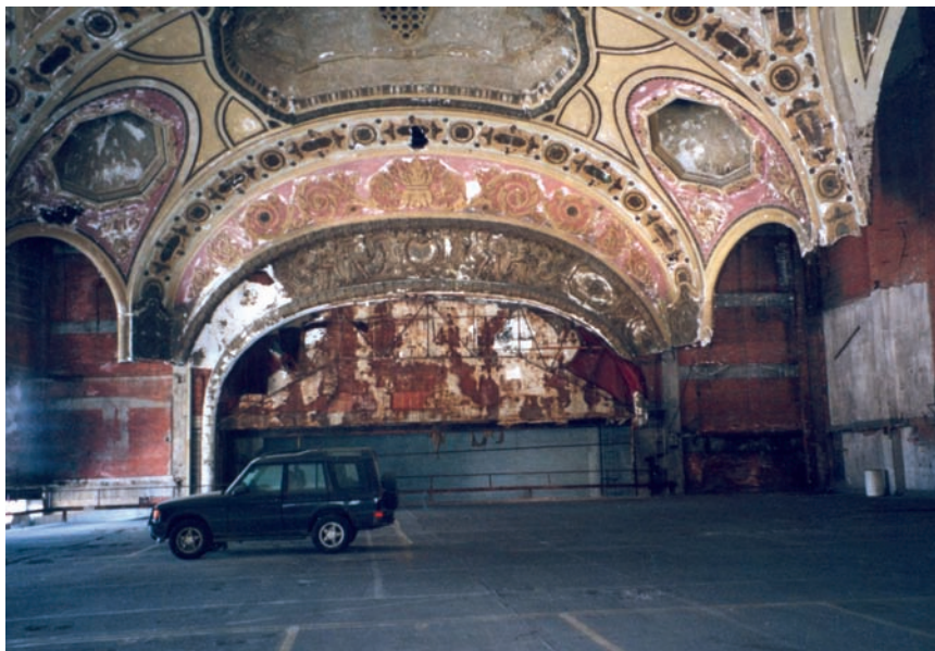
Przykłady destrukcji przestrzennej miasta Fot. 2. Wnętrze przekształconego w parking Michigan Theater Symptoms of urban decline The Michigan Theater, transformed to a car park
