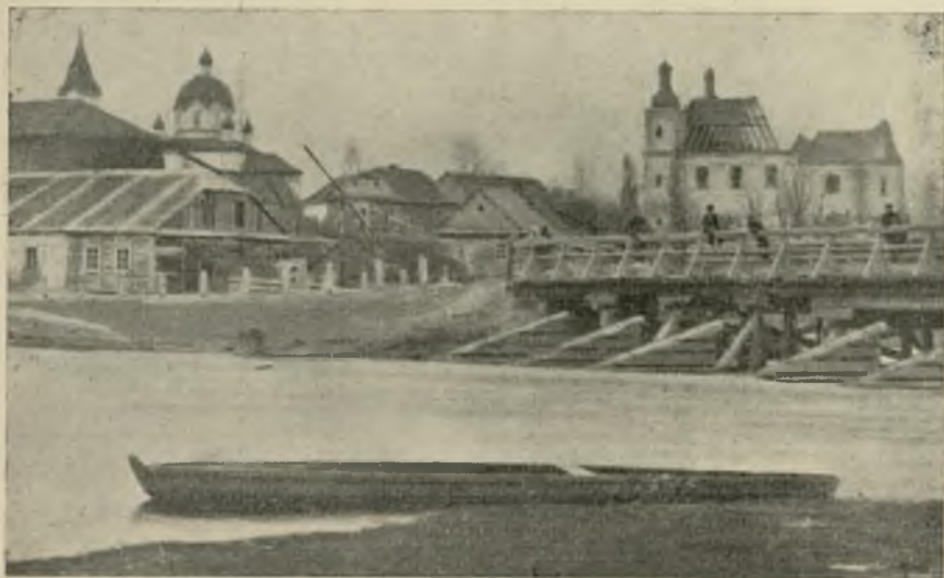
Rys. 21. Widok na kościół z zawalonym dachem w 1927 r.
