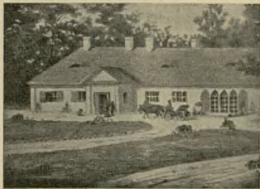
Ryc. 33. Fotografia Gródka z przed 1880 r. Widoczna jest dobudowa prawego skrzydła domu, dokonana przez Kraszewskiego.
