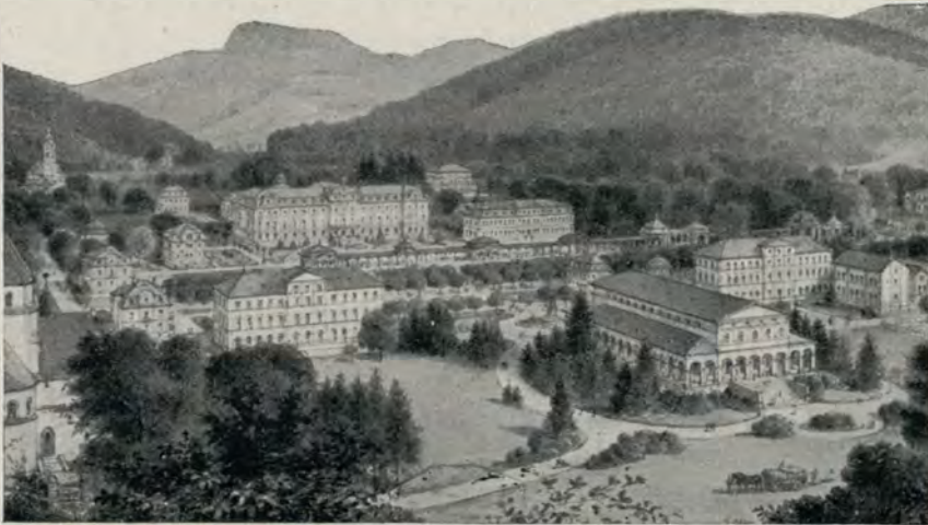
Bad Brückenuau. Gesamtansicht
