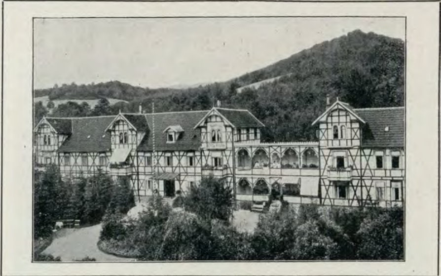
Sanatorium Otto Stubbe (Ansicht von Süden).
