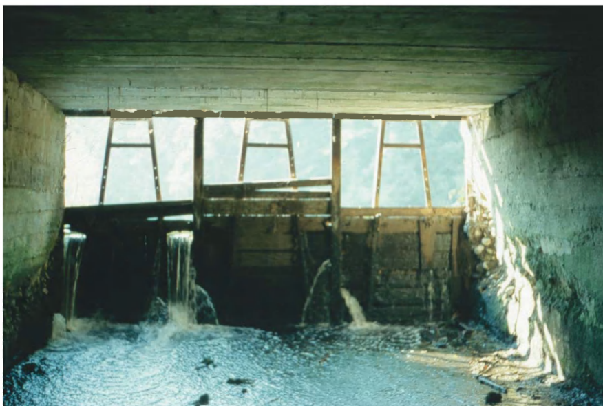
Fot. 3. Jaz stawu młyńskiego w Brzozówce na Skrwie Lewej Weir of the Brzozówka mill pond (Skrwa Lewa River)
