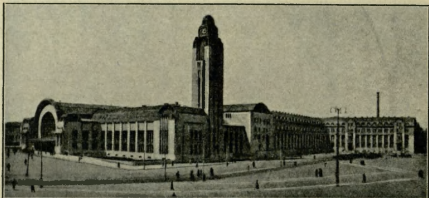
Ryc. 131. Helsingfors, stolica Finlandji. Główny dworzec kolejowy.
