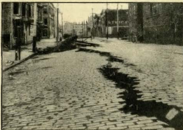
Ryc. 20. Szczelina i obsunięcie się ziemi skutkiem trzęsienia ziemi w San Francisco (Stany Zjedn. Am. Pn.).
