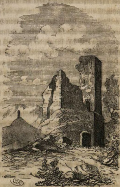
Der Crifels. Hauptturm.
