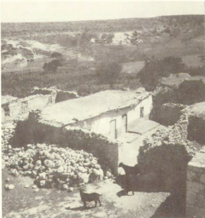
Fot. 42. Gökce: dom skrzynkowy, czerkieski z kamienia, ściany wyprawione i malowane Gökce: a Circassian stone cube house with plastered and painted walls
