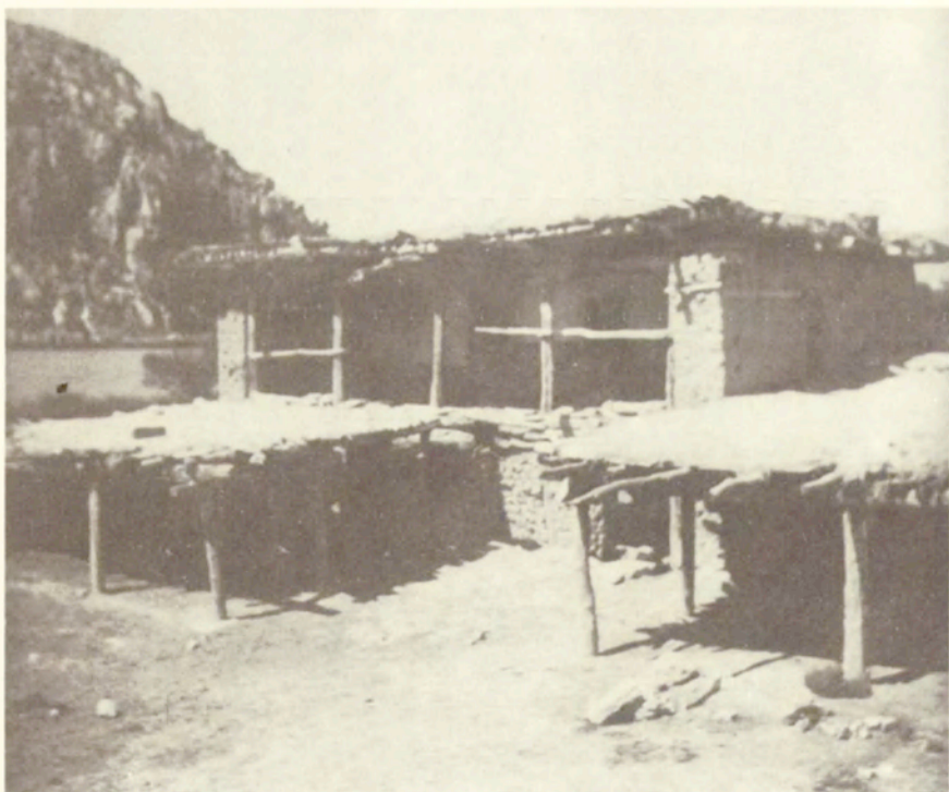
Fot. 35. Karīpçe: dom skrzynkowy, piętrowy z podcieniami Karīpçe: a two-storey cube house with arcades
