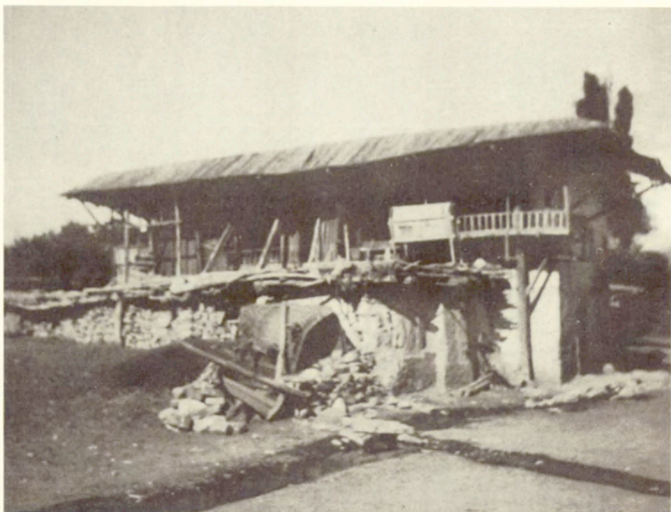
Fot. 31. Zivint turecki: dom çardak – piętro częściowo obudowane, chronione drewnianym póldaszkem
