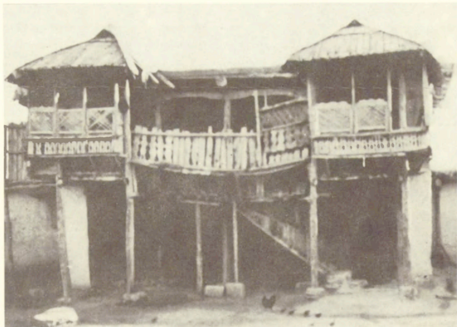
Fot. 43. Zivint czerkieski: dom piętrowy, drewniany z podcieniem Circassian Zivint: a two-storey wooden house with arcades
