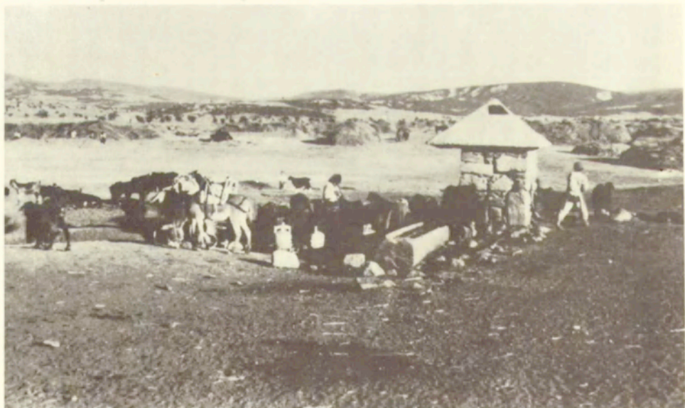
Fot. 40. Eber: studnia grawitacyjna z bieżącą wodą (kanat) Eber: a gravitation well with running water (kanat)
