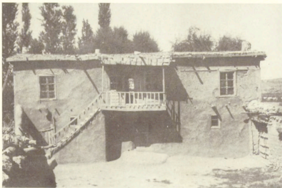
Fot. 27. Gökce: dom skrzynkowy, piętrowy, ściany wyprawione, duże okna Gökce: a two-storey cube house, plastered walls, large windows
