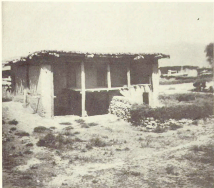
Fot. 30. Karīpçe: dom piętrowy, podcieniowy z cegły suszonej Karīpçe: a two-storey house with arcades of dried bricks
