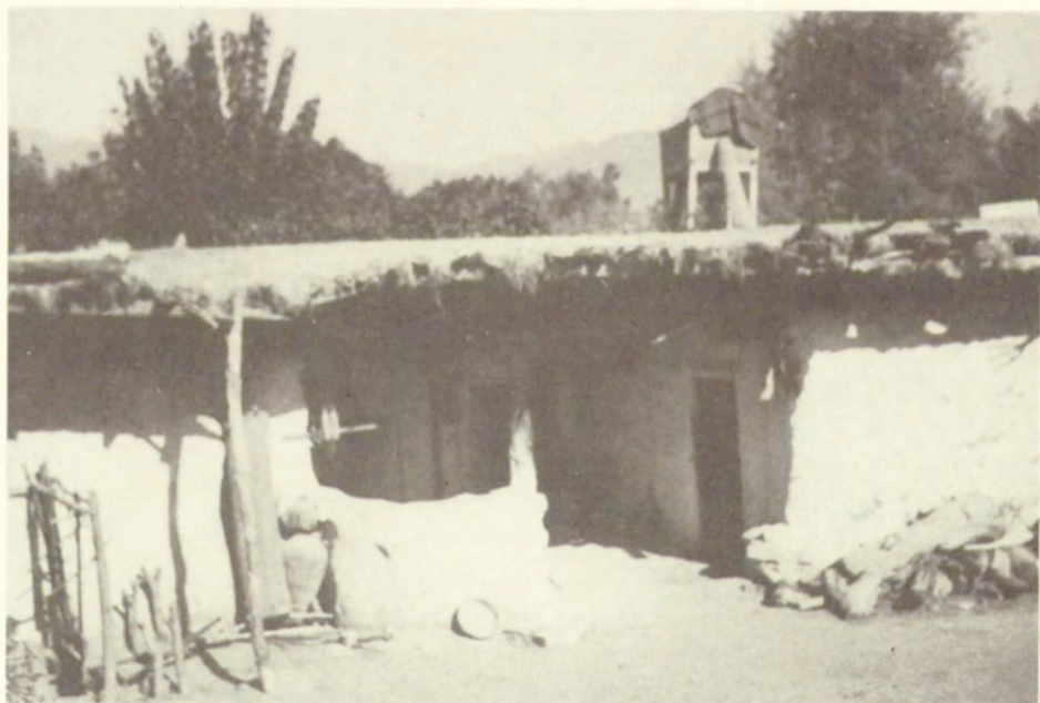
Fot. 28. Zivint: dom skrzynkowy z kamienia, dach płaski z okapem, na nim platforma do spania. Podcień (sień) wykorzystywany jako kuchnia
