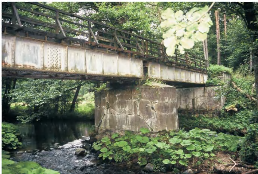
Fot. 2. Dawny most kolejowy przez Skotawę na lokalnej linii normalnotorowej Słupsk–Budowo, rozebranej w 1945 r.
