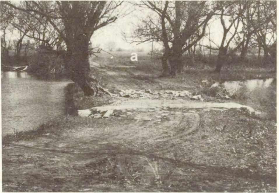
Fot. 6. Fragment zabudowy hydrotechnicznej koryta Wisły pod Toruniem (ostroga) wraz z powierzchnią nowo powstałego poziomu zalewowego (a)
