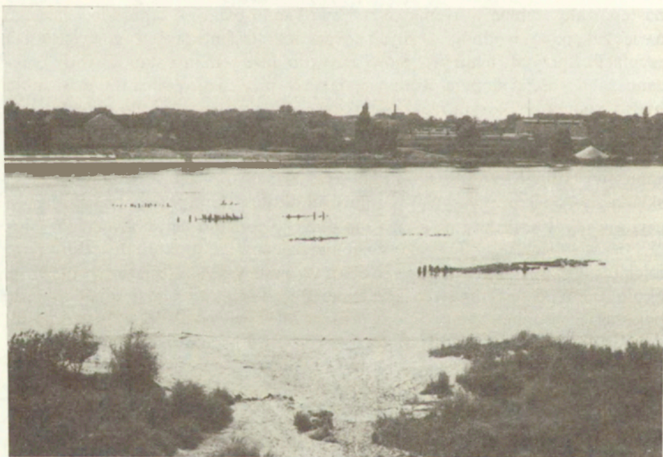
Fot. 9. Wynurzone fragmenty drewnianych pali po dawnym moście drogowym we Włocławku — jako efekt erozji wgłębnej poniżej zbiornika
