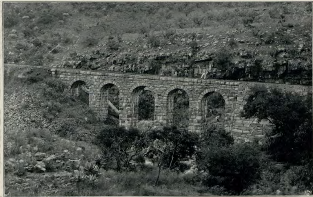
Eisenbahn- Viadukt bei Waterval Boven am Krokodilflusse.
