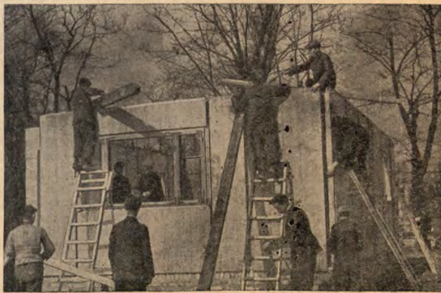
Montaż składanych domków, ofiarowanych
