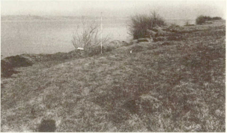
Fot. 14. Abrazyjny brzeg zapory bocznej w Modzerowie spiętrzony w formie wału egzaracyjnego przez napór pokrywy lodowej Abrasive bank of the lateral dam in Modzerowo, banked in form of plucking dike by the ice cover pressure 15 IV 1986
