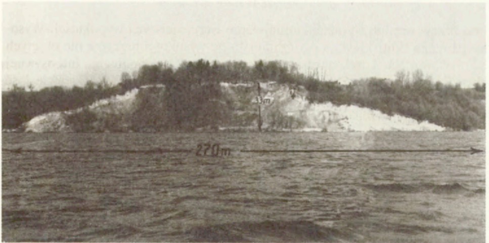
Fot. 12. Permanentna przewaga procesów stokowych nad brzegowymi w Bachorzewie (km 665,2) — czoło osuwiska tworzy wypukłość linii brzegowej. Porównaj z ryc. 20a
