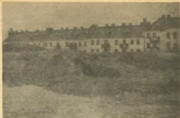
Ryc. 3. Warszawa — Żoliborz, plac Lelewela. Odstąpienie w dolnej części plantowanego zbocza wysokiego brzegu doliny Wisły, 1933 r.
