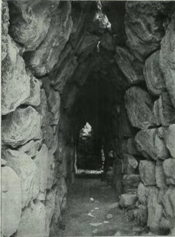
Abb. 396. Galerie in Tiryns, aus mächtigen unbehauenen Felsblöcken, durch deren Übertragung der Spitzbogen gebildet wurde.
