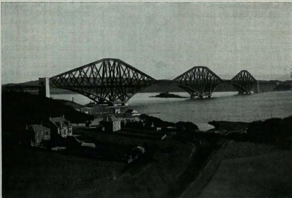
Abb. 429. Die große Forthbrücke bei Edinburg, eine der größten Eisenbahnbrücken der Erde, sechsundvierzig Meter über dem Hochwasserspiegel, mit Spannweiten von einem halben Kilometer.
