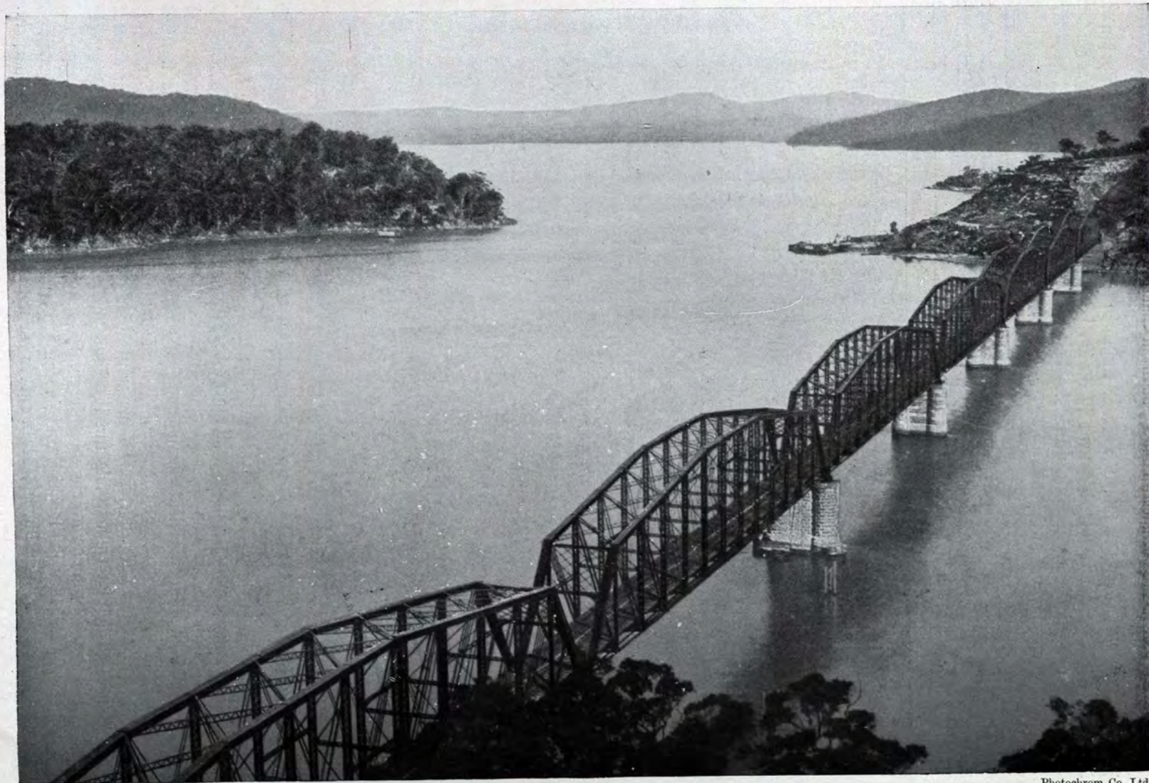
Abb. 431. Die Hawkesburybrücke, die bedeutendste Australiens, über einviertel Kilometer lang, mit Spannweiten von hundertfünfunddreißig Meter; des Schlammbodens wegen mußten die Pfeiler in der Strommitte auf fünfundfünfzig Meter Tiefe unter dem Stromgrund fundiert werden.
