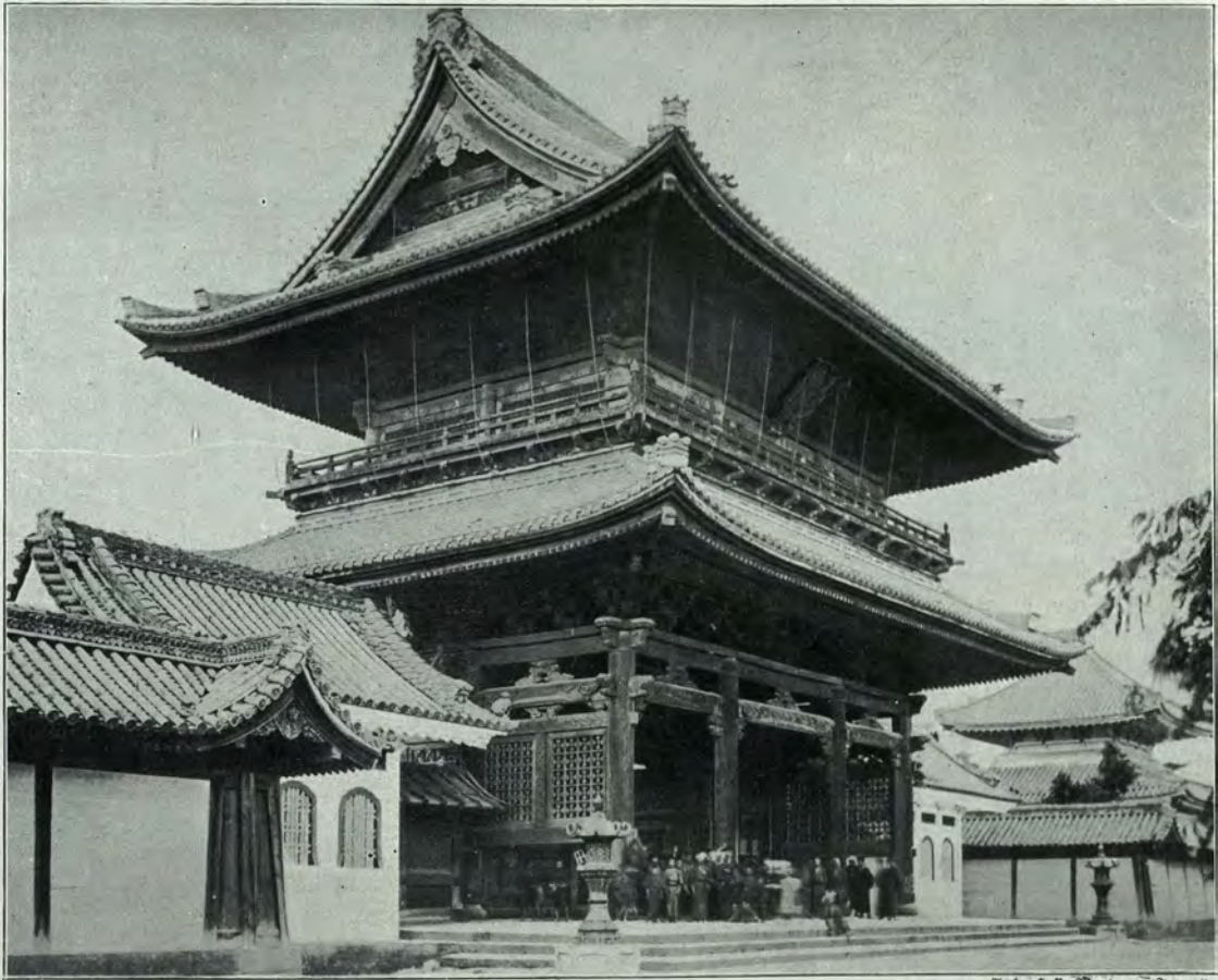
Abb. 403. Großes Eingangstor zum Hongwandschitempel in Nagoya.
