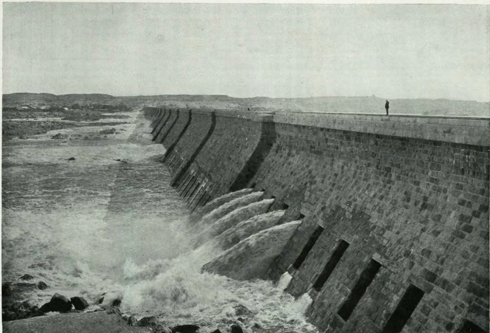
Abb. 92. Der große Staudamm bei Assuan, die größte Talsperre der Welt, über zwei Kilometer lang, mit hundertachtzig Schleusen. Er staut das Wasser des Nils auf zwanzig Meter Höhe und dient zur regelmäßigen Bewässerung von zweitausend Geviertkilometer Land.
