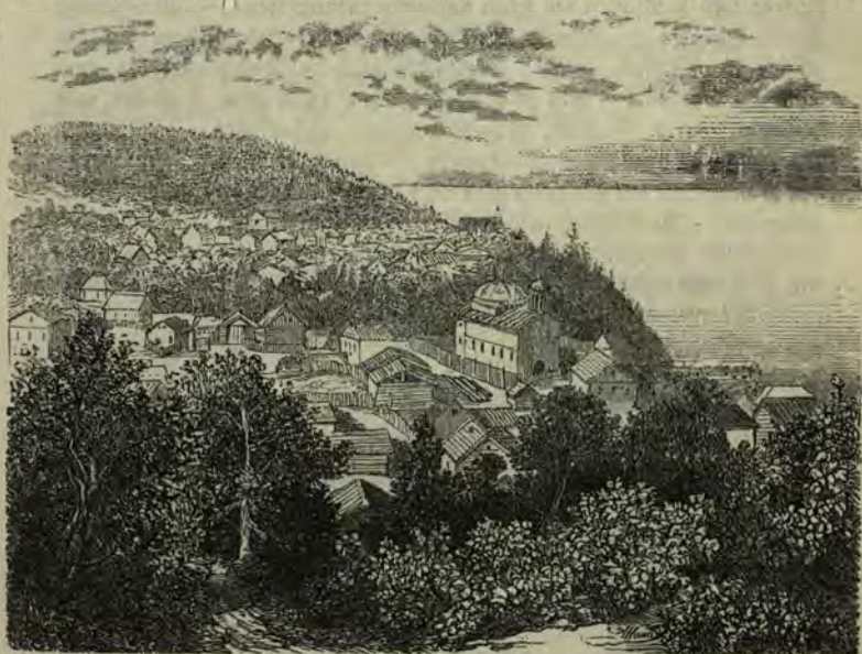
Kirchdorf an einem sibirischen Flusse. nach einer Photographie.
