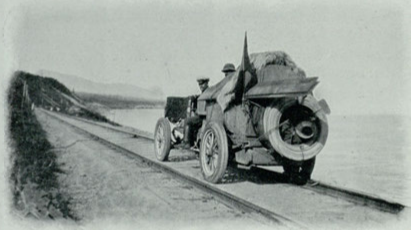
Auf der Strecke der sibirischen Eisenbahn in Begleitung des Gendarmen.
