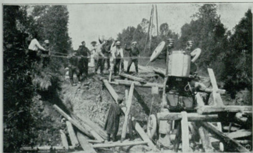
Freimachung von den Brückenresten.
