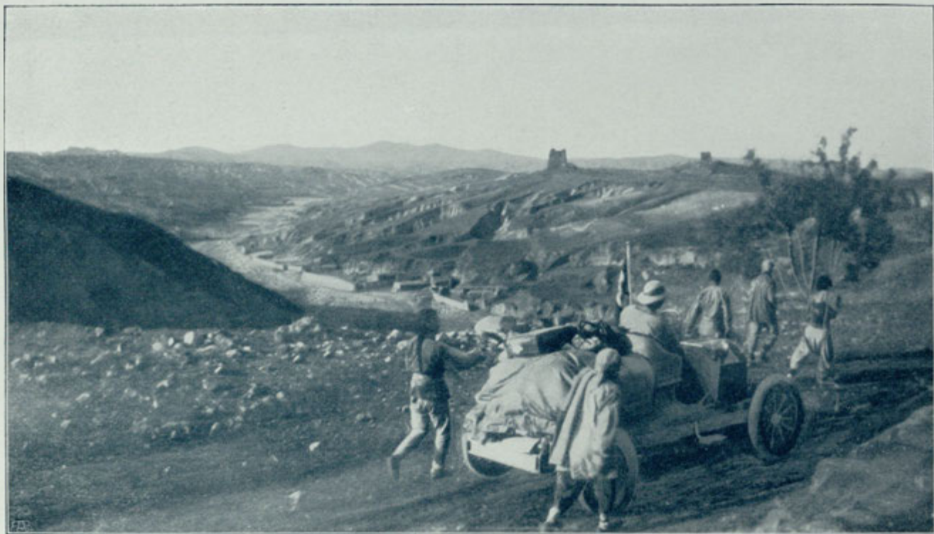
Ausicht in das Schi-Schan-jo-Tal mit den Türmen der äußersten Großen Mauer.
