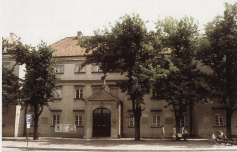
65. Średnia szkoła pijarska w Łowiczu po odbudowie (wiek XVII).
