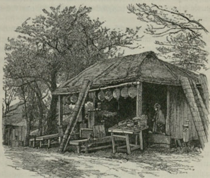
Theehaus an der Straße.
