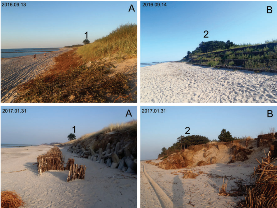
Fot. 6. Dokumentacja fotograficzna zmian morfologicznych zachodniej części mierzei jeziora Kopań A – erozja stoku niskiej wydmy i zniszczenia faszyny 268 km (1 – wysoka sosna), B – zniszczone umocnienie z faszyny przy kanale Kopań, rejon 264,5 km (2 – kępa sosen)
