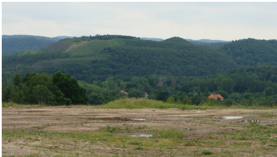
Fot. 1. Zrekultywowana największa hałda Zagłębia Wałbrzyskiego (9–2 o powierzchni 50,0 ha, objętości 23 077 tys. m 3 oraz wysokości 105 m; fot. J. Wójcik) Now reclaimed, what was the largest spoil heap in the Wałbrzych Basin (9-2: A 50.0 ha, V 23077 thous. m 3 , H 105 m)
