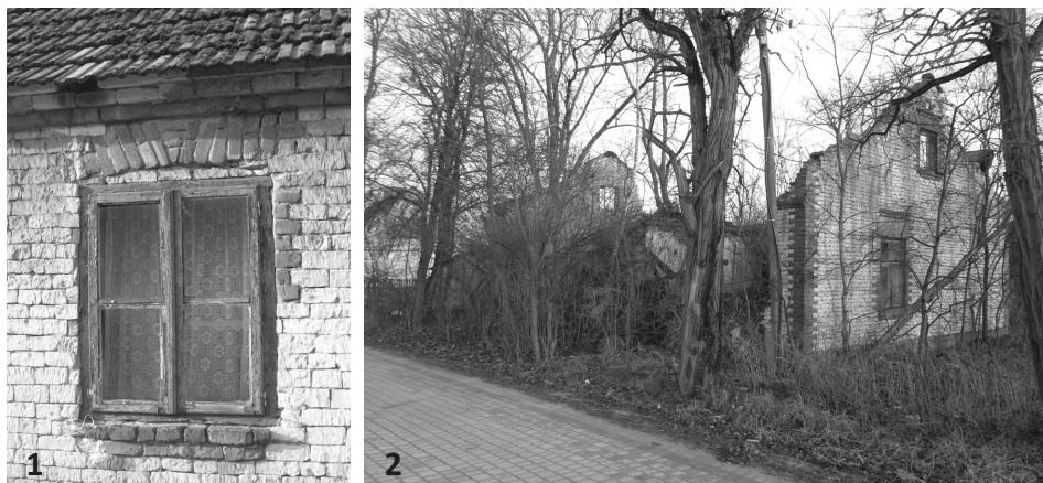
Fot. 1. Budulec: opoka z Różniatowa (Fot. Pamela Jeziorska-Biel, podobnie następną) Construction material: rock from Różniatów village (Photo: Pamela Jeziorska-Biel, next photo also)
