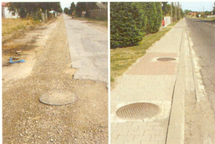
Fot. 4. Rozbudowa sieci kanalizacyjnej na obszarach wiejskich Mazowsza – gmina wiejska Sierpc i okolice Gostynina (gm. Szczawin Kościelny) Development of the sewerage system in rural areas of the Mazovia province – a rural commune Sierpc and the area in the vicinity of Gostynin (Szczawin Kościelny commune)
