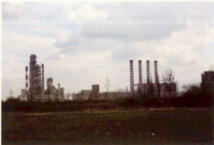
Fot. 5. Cementownia w Chełmie (fot. J. Bański) Cement mill in Chełm (photo J. Bański)
