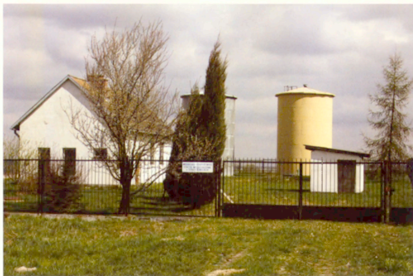
Fot. 7. Stacja wodociągowa w Strzyżewicach (fot. J. Bański) The water-supply station in Strzyżewice (photo J. Bański)
