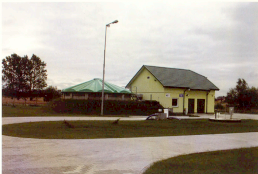
Fot. 8. Nowa oczyszczalnia ścieków w Zalesiu w powiecie białopodlaskim (fot. J. Bański) New wastewater treatment plant in Zalesie in the district of Biała Podlaska (photo J. Bański)
