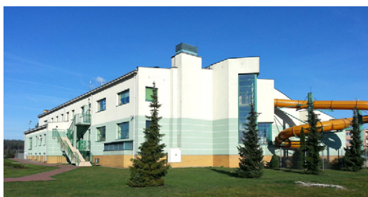
Fot. 11. Kryta pływalnia w Mławie w sąsiedztwie stadionu (S. Kozłowski) Photo 11. Kryta pływalnia w Mławie w sąsiedztwie stadionu (S. Kozłowski)
