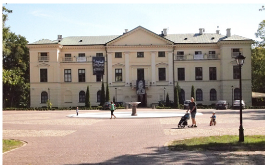
Fot. 6. Mińsk Mazowiecki, Dom Kultury w Pałacu Dernałowiczów (S. Kozłowski) Photo 6. Mińsk Mazowiecki, Cultural Centre in the Dernałowicz Palace (S. Kozłowski)
