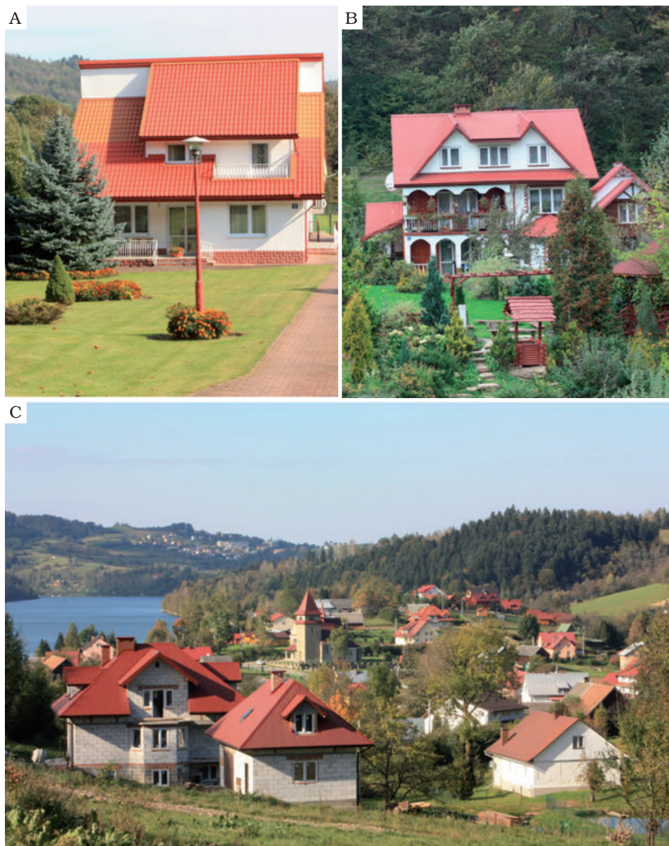
Ryc. 29.14. Nowe budownictwo jednorodzinne – przykłady elementów obcych w krajobrazie regionu: A – Baligród, B – Górzanka, C – Zawóz (fot. J. Wolski, 2010)
