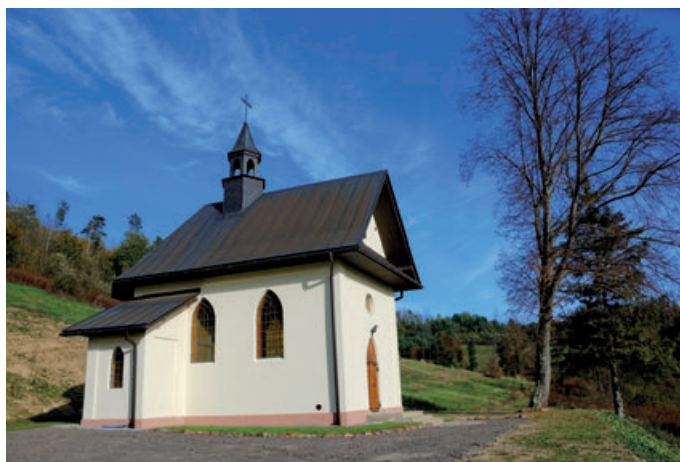
Ryc. 46.20. Odremontowana kaplica rzymskokatolicka z 1932 r. w Żernicy Niżnej (fot. P. Szechyński, 2013)
