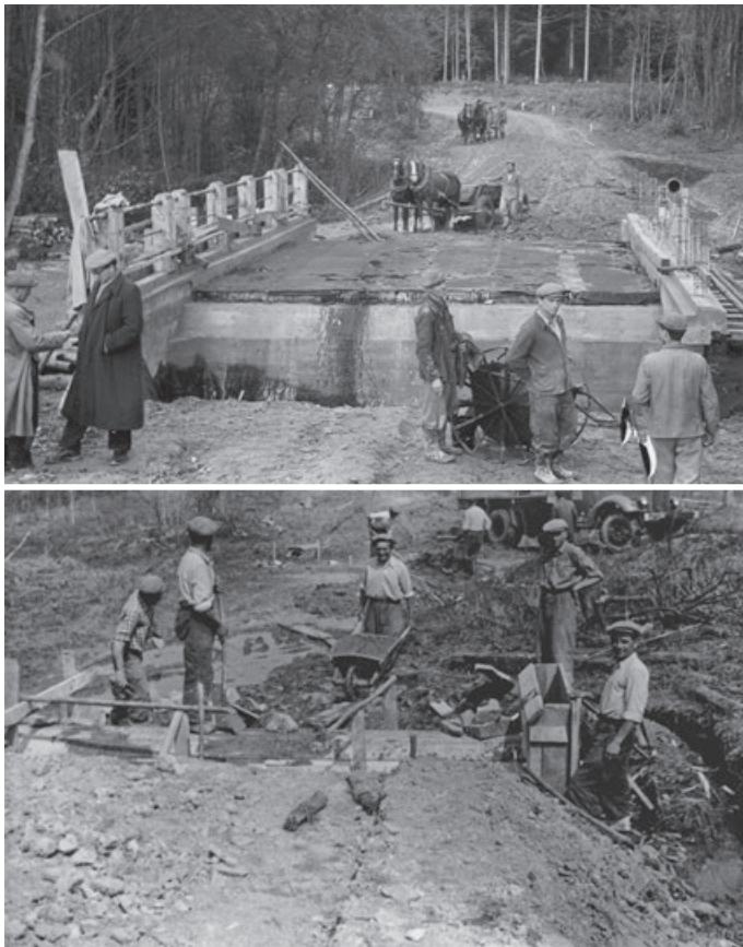
Ryc. 39.3. Budowa mostu i przepustu na drodze leśnej w Nadleśnictwie Lutowiska (Archiwum RDLP w Krośnie, 1959)
