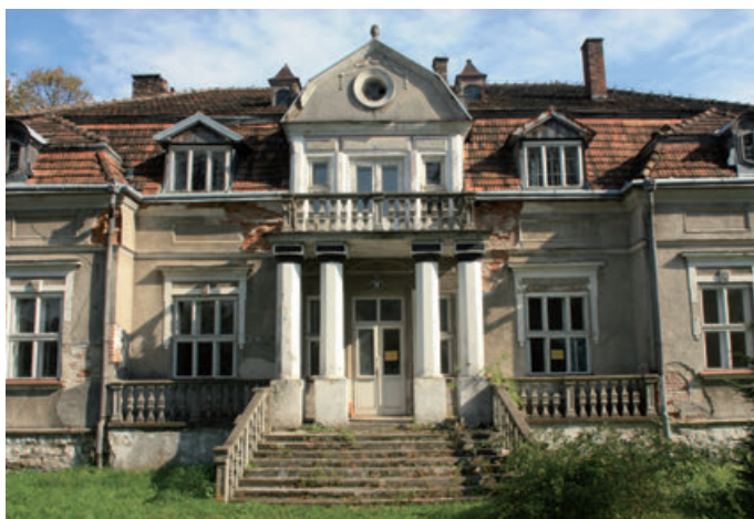
Ryc. 29.9. Willa doktora Włodzimierza Kuźmaka (tzw. „Kuźmakówka” lub „willa notariusza”) w Baligródzie – stan w 2010 r.; obecnie, po remoncie przeprowadzonym w latach 2011-2012, budynek jest siedzibą Nadleśnictwa Baligród (fot. J. Wolski)
