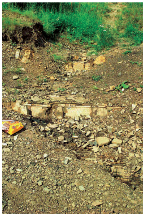
Ryc. 43.9. Unikalne stanowisko wapienia tylawskiego na parkingu (dawny kamieniołom) na Przełęczy Wyżniańskiej; stan z połowy lat 90. XX w. (fot. G. Haczewski)
