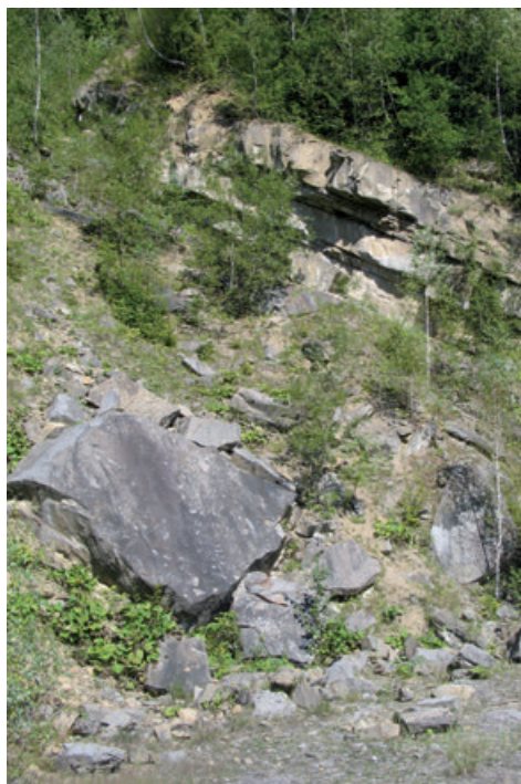
Ryc. 43.6. Nieczynny kamieniołom w Krywym przy drodze Sękowiec–Rajskie – pomnik przyrody nieożywionej; stan w 2008 r. (fot. J. Wolski)
