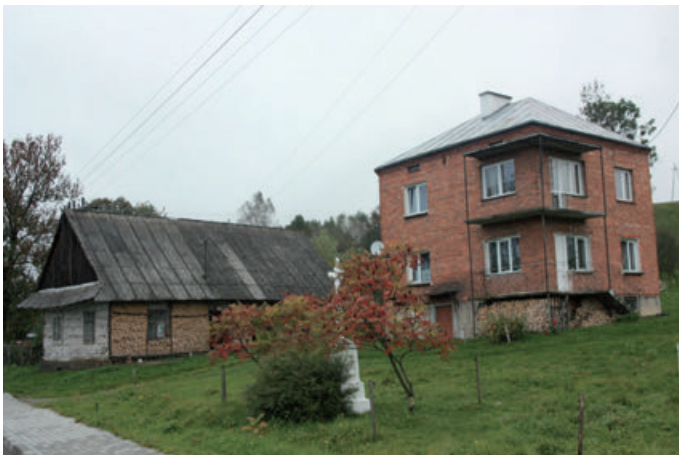
Ryc. 29.13. Dom typu kostka, powszechny w czasach PRL-u, w sąsiedztwie przedwojennej chyży w Czarnej Górnjej (fot. J. Wolski, 2010)
