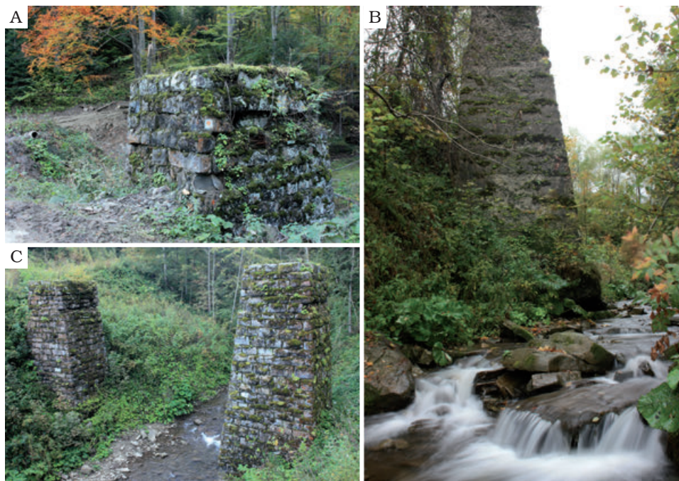
Ryc. 32.11. Filary dawnych mostów kolejki wąskotorowej: A – przy drodze Muczne–Tarnawa Niżna, B – przy drodze Muczne–Tarnawa Niżna nad potokiem Roztoki, C – u ujścia potoku Zwir do Wołosatego (fot. J. Wolski, 2010)
