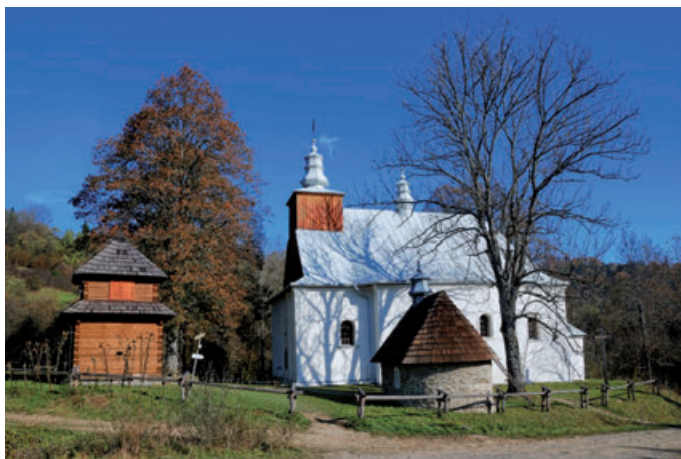
Ryc. 46.12. Odremontowana cerkiew pw. św. Męczennicy Paraskewy w Łopience wraz z drewnianą dzwonnica i murowaną kaplicą grobową (fot. P Szechyński, 2013)
