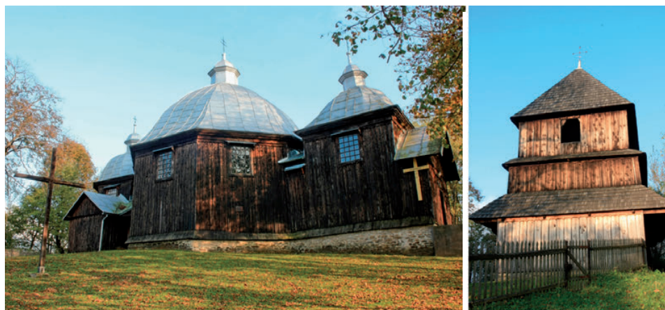
Ryc. 21.12. Cerkiew pw. Narodzenia NMP z 1863 r. w Michniowcu, elewacja północna; po prawej dzwonnica o konstrukcji zrębowo-słupowej z 1904 r. (fot. J. Wolski, 2010)
