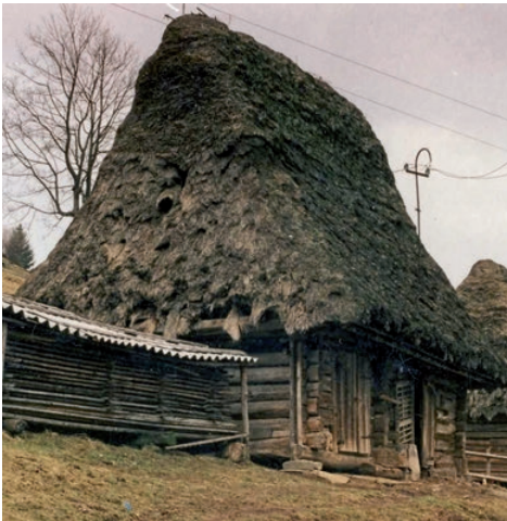
Ryc. 20.22. Budynek gospodarczy: boisko ze stajnią sprzed 1939 r. – Jelenkowate, rej. skolski (fot. J. Czajkowski, 1997)
