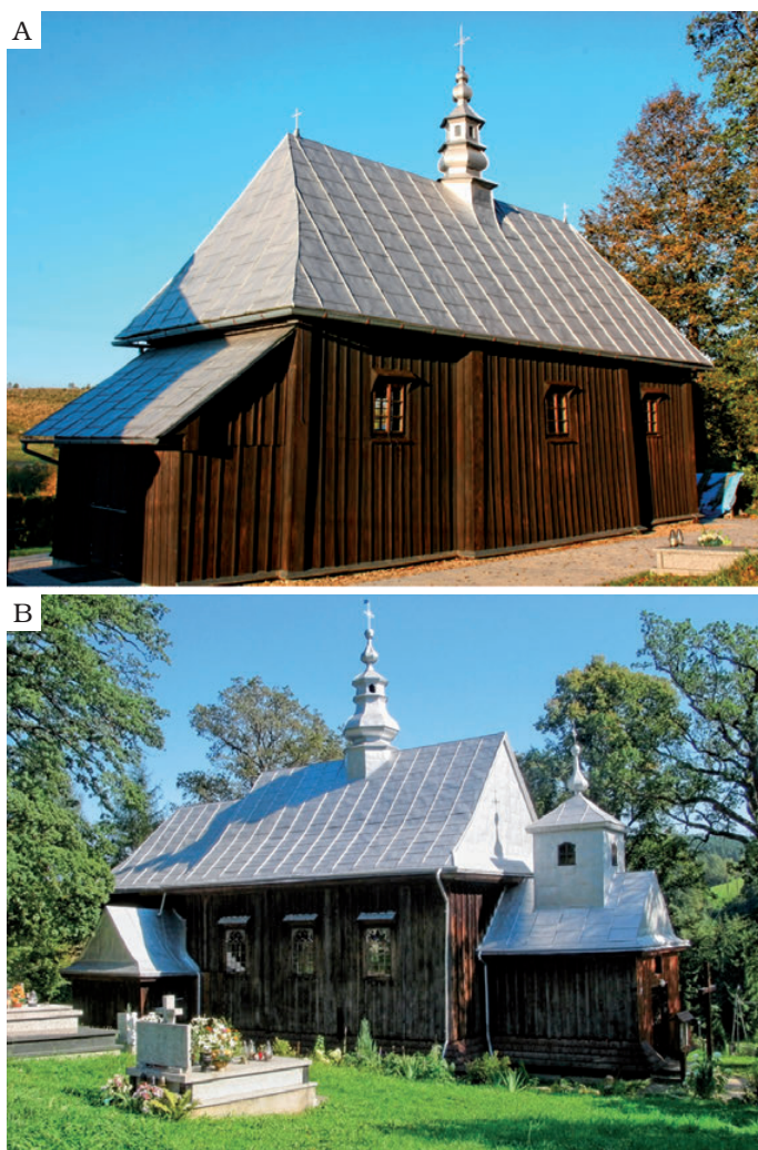
Ryc. 21.13. Przykłady dachów kalenicowych: A – cerkiew pw. św. Mikołaja z 1830 r. w Bereźnicy Wyżnej, B – cerkiew pw. św. Paraskewy z 1838 r. w Górzance (fot. B. Wolska, 2008, 2010)
