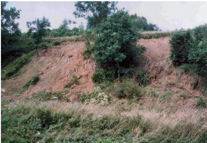
Ryc. 7.7. Zerwy i spływy ziemne na stromych zboczach doliny Bereźnicy w Woli Matjaszowej po ulewie w dniu 26.07.2005 r. (fot. L. Starkel, 2005)
