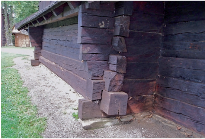
Ryc. 21.6. Cerkiew pw. Opieki NMP z 1. połowy XVIII w. w Równi, zwęglowanie nawy (fot. K. Warمیńska-Mazurek, 2010)
