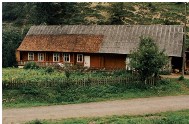
Ryc. 20.26. Dom: dwie izby w amfiladzie, sienią przelotową z oknem, boisko, stajnia, XX w. – Różanka Wyżna, rej. skolski (fot. J. Czajkowski, 1997)
