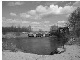
Fot. 4. Zabytkowy most kolejowy Pic. 4. Historic rail bridge
