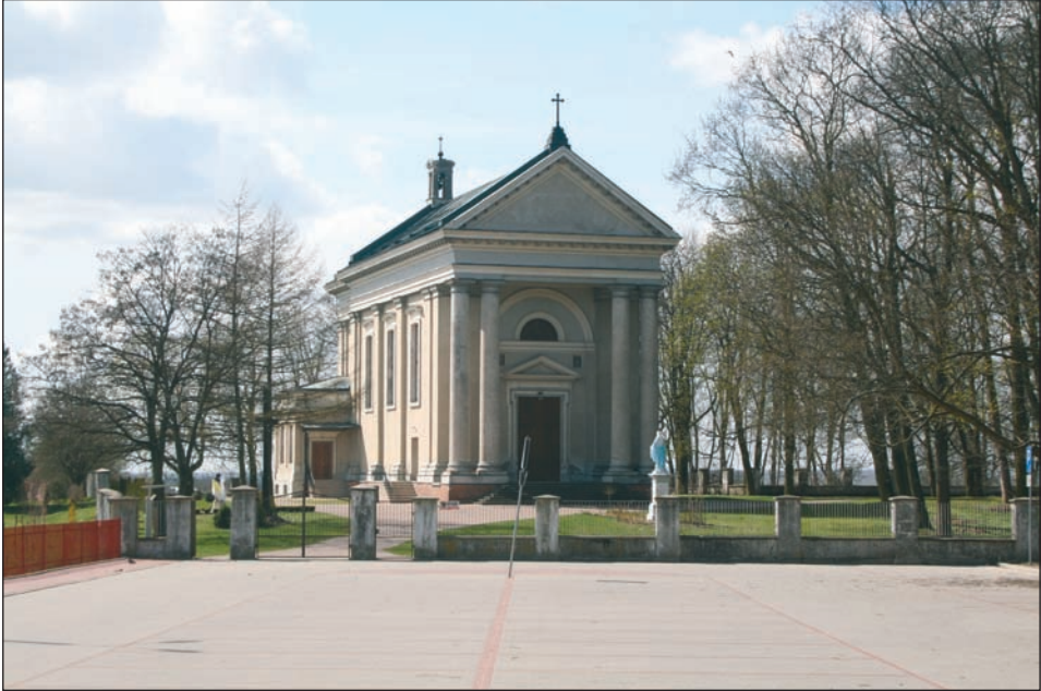
Ryc. 8. Kościół fundacji Róży z Potockich Krasieńskiej z lat siedemdziesiątych XIX w., który zastąpił rotundę. Kaplica grobowa Krasieńskich rozciąga się pod całą długością kościoła, stanowiąc z kościołem jedną bryłę. Fot. W.J. Górczyk
