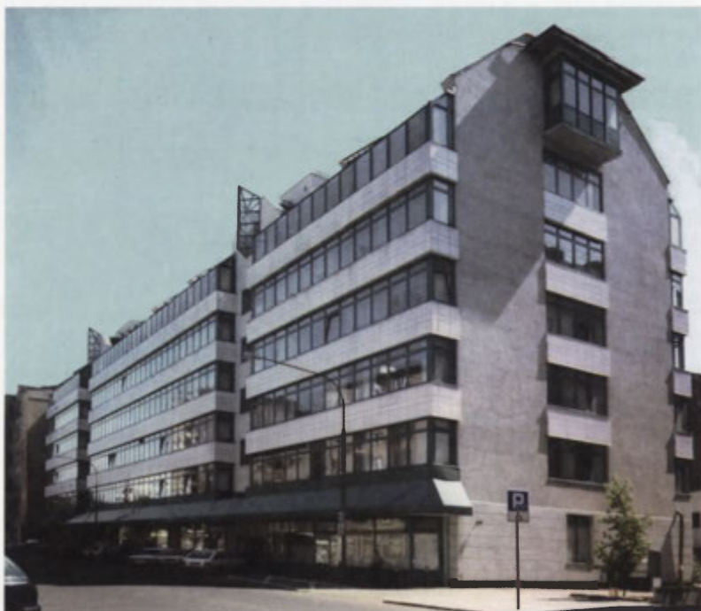
Fot. 2. Siedziba Instytutu przy ul.Twardej 51/55 w Warszawie od 1997 r. The Institute's headquarters at Twarda St 51/55 in Warsaw since 1997
