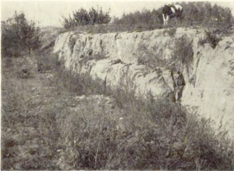
Fot. 14. Uskok powstały wiosną 1967 r. ze ścięcia utworów budujących zbocze doliny Wisły w Dobrzyniu — 660,4 km. Zrzucona część jest płaska, bez szczelin, pod uprawą. Widoczna dwudzielność górnej gliny zawałowej (październik 1969)
