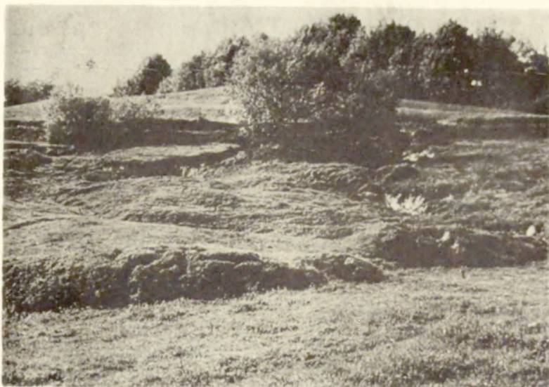
Fot. 31. Osuwisko—złazisko rozwijające się na zadarnionym stoku doliny Wisły w Kamienicy (Soczewce) — 657,9 km. Wyraźne od- młodzenie na skutek silnego przesylenia wodami roztopowymi i podziemnymi wiosną 1970 r. W okresie następnych trzech lat nie stwierdzono tak intensywnego ruchu (maj 1970)
