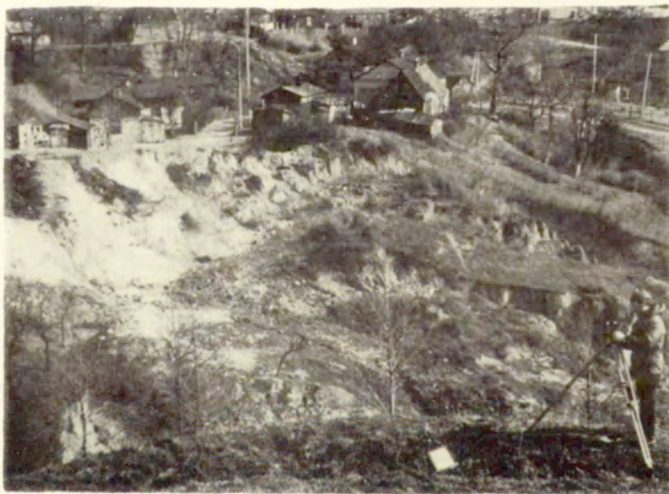
Fot. 26. Północna część niszy osuwiska centralnego w Dobrzyniu. Ulica Podzamcze nieprzejezdna, na znacznym odcinku „włączona” w nurt osuwiska (kwiecień 1973)
