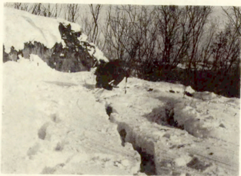
Fot. 15. Szczeliny w stopniu powstałym wiosną 1967 r. na zboczu w Dobrzyniu — 660,4 km (listopad 1969)
