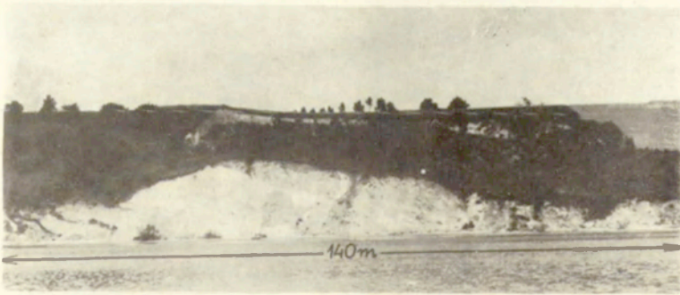
Fot. 27. Bachorzewo (664,2 km). Osuwisko powstało wiosną 1967 r. w łęku fałdu utworów plioceńskich. Warstwy osadów budujących wysoki brzeg zapadają przeciwnie do nachylenia zbocza (lipiec 1973)
