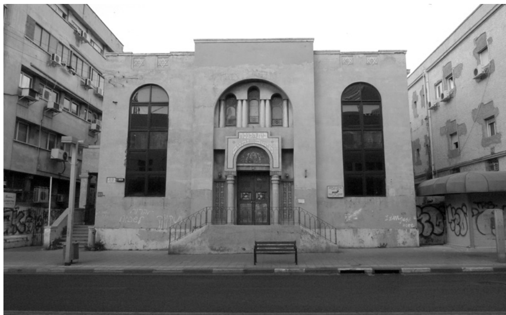
Fot. 1. Synagoga Moshav Zekenim w Tel Awiwie (arch. Yehuda L. Magidovitch, 1928), fot. autor
