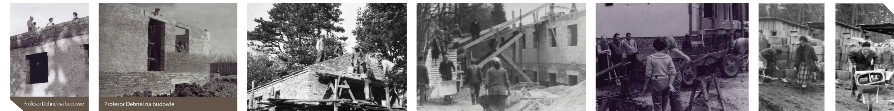
Prace przy budowie
