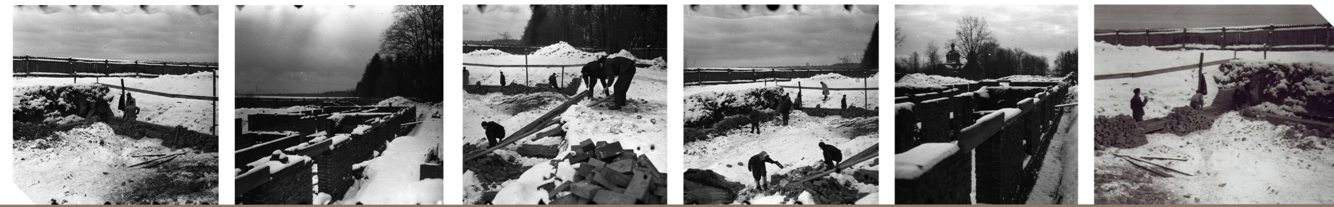
Grudzień 1958. Pierwsze wykopy i praca przy fundamentach
