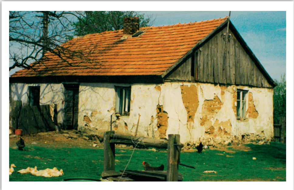
Fotografia 7.1. Dom zbudowany z użyciem lokalnych materiałów: kamienia, gliny i palonej cegły – wieś Modzerowo w dolinie Wisty
