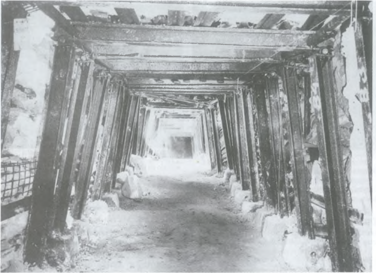
Ryc. 33. Rijckholt – St. Geertruid, prov. Limburg (Holandia). Kopalnia krzemienia. Sztolnia wydrążona w skale kredowej zbocza doliny Mozy, służąca badaniom podziemnych wyrobisk. Stan z 1975 r. Fot. P.J. Felder.
