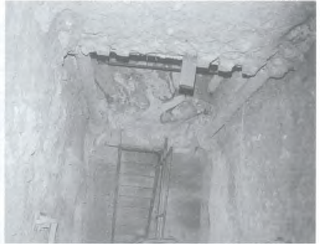
Ryc. 32. Krzemionki Opatowskie. Szyb „0” – wejście/wyjście na trasę turystyczną nr 2. Widok z góry – fragment. Por. ryc. 31. Fot. J. Lech.
