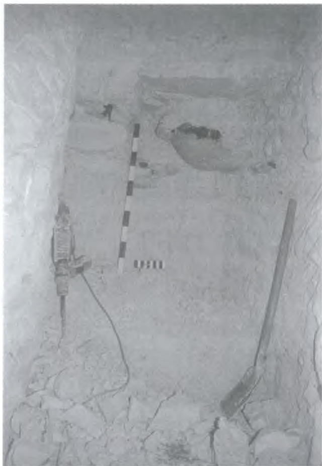
Ryc. 36. Krzemionki Opatowskie. Chodnik łączący szyb wentylacyjno-komunikacyjny z trasą turystyczną nr 2 w czasie drążenia, w dniu 16 sierpnia 2001 r. W ścianie przodka widoczne kongrecje krzemienia. Skale 1 m oraz 20 cm. Fot. J. Lech.
