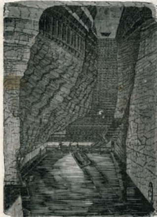
KOMORA PRZYKOS OD STRONY ZACHODNIEJ.
