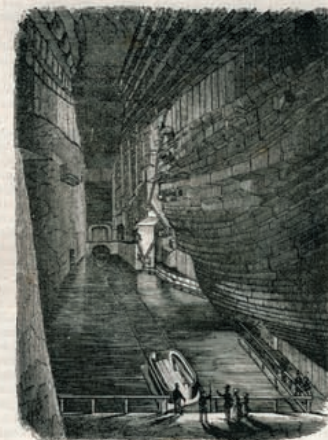
KOMORA PRZYKOS OD STRONY WSCHODNIEJ.
