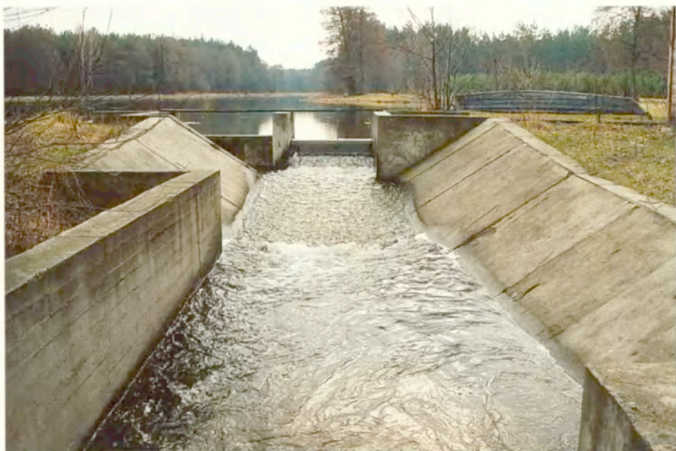
Fot. 1. Przelew kontrolno-pomiarowy na strudze Ruda The control-measurement weir on stream Ruda
